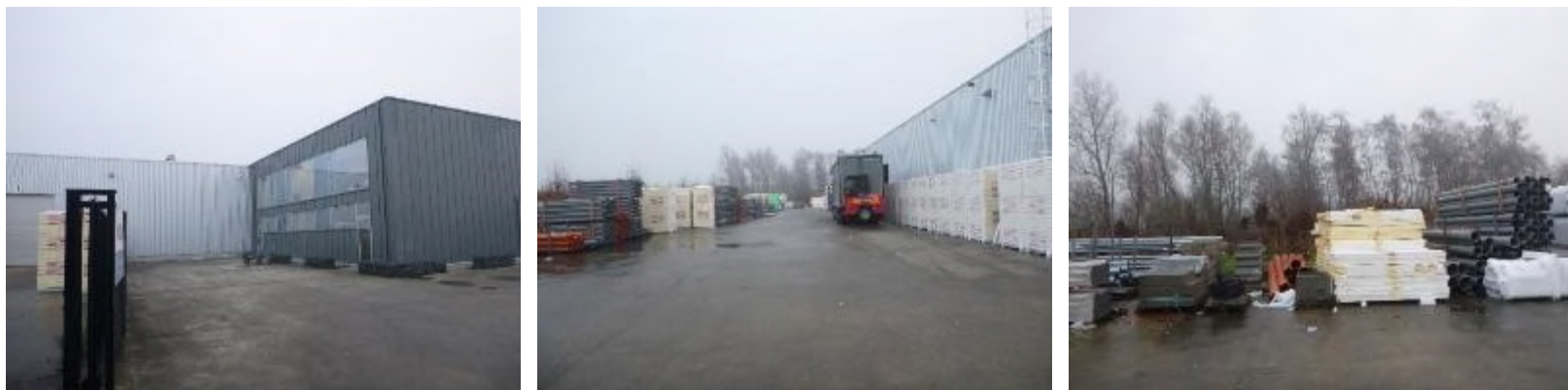
Foto's bestaande toestand (d.d. 20/12/2017)
