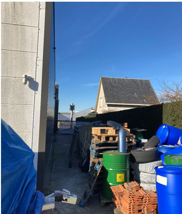
| foto 3: gedeelte van de geplaveide buitenruimte wordt gebruikt voor stockage
