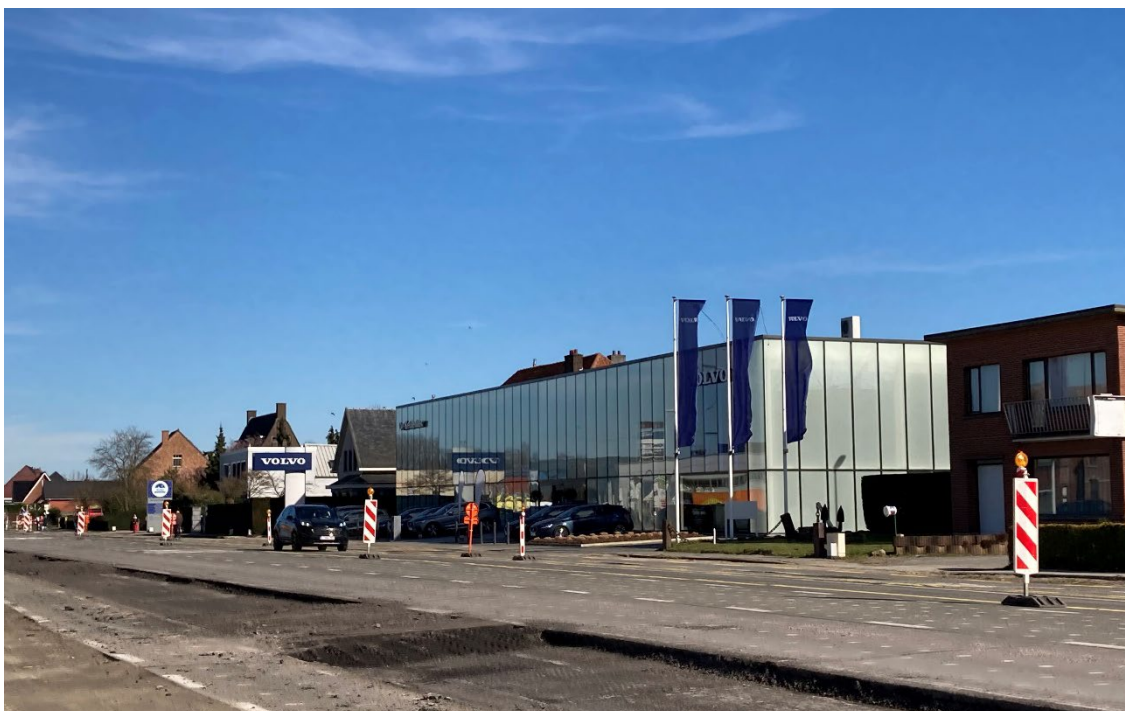
| foto 1: voorgevel van het garagegebouw
