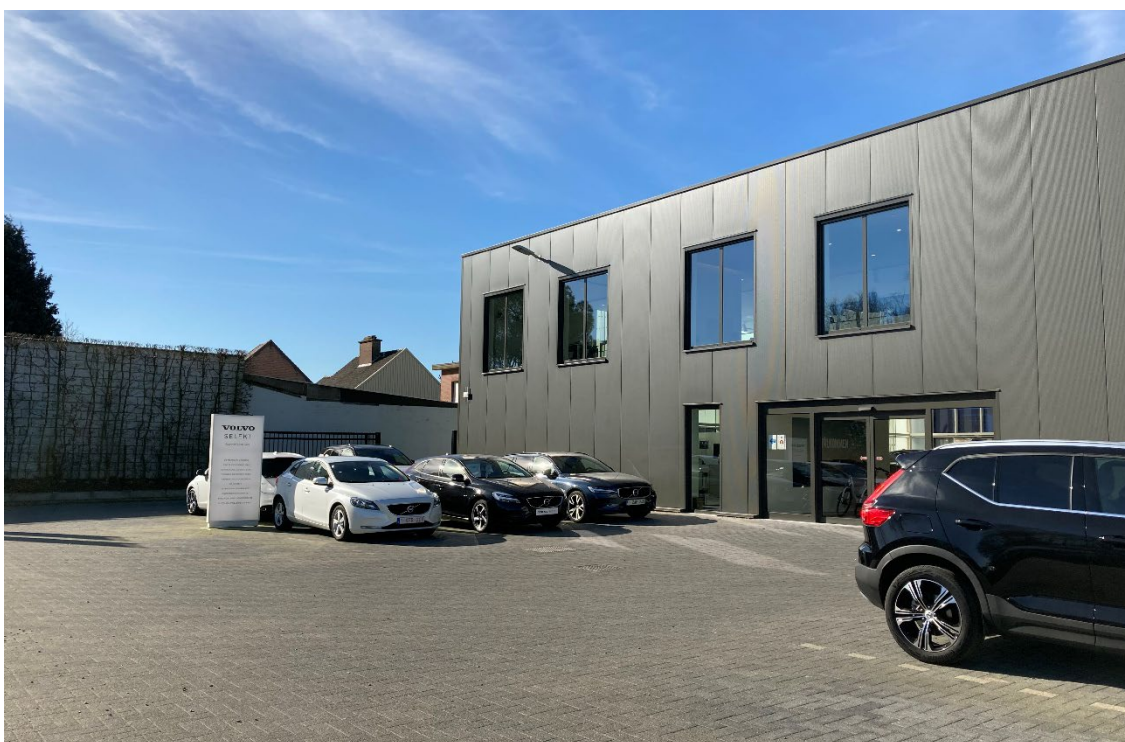
| Foto 2: geplaveide autostalplaats voor occasionewagens aan de achtergevel
