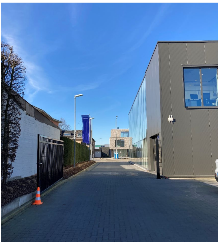
| foto 4: geplaveide doortrit voor wagens langs de westelijke gevel
