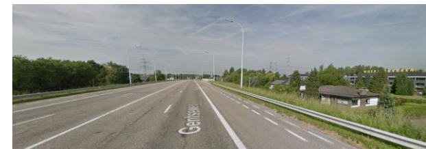
Foto 4 : Profiel N70-Gentseweg (viaduct)
